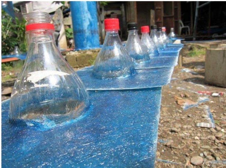
Una vez preparada la mezcla, se hace un orificio en una lámina de zinc o fibra de vidrio, donde se inserta la botella hasta la mitad. A continuación se perfora un agujero similar en el techo de la casa y se ajusta con firmeza el artefacto, teniendo como tope la pequeña lámina. Finalmente se aplica un sellador potente para evitar filtraciones. Este es el resultado:
